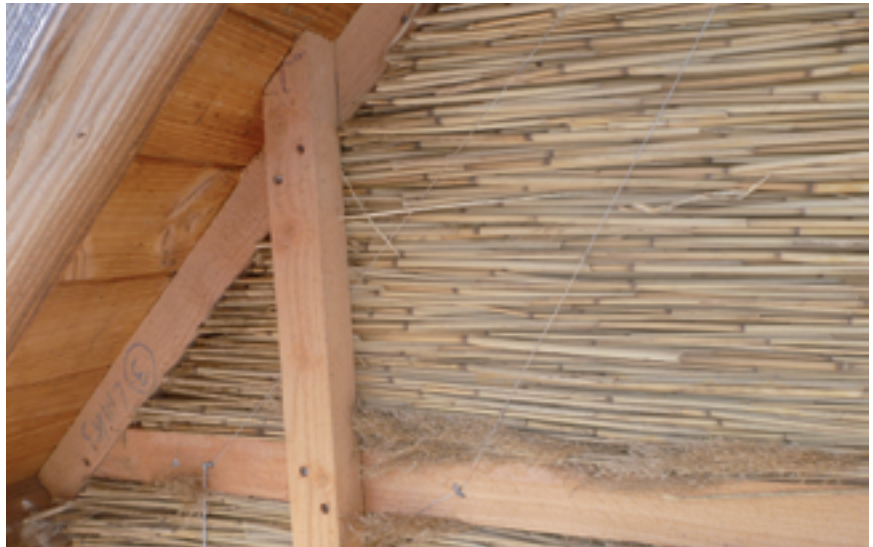
Soweit möglich wurden zukunftsfähige Materialien eingesetzt, wie hier die erste Lage der zweilagigen Schilfdämmung. Sie wurde mit Lehm und Kalk verputzt
