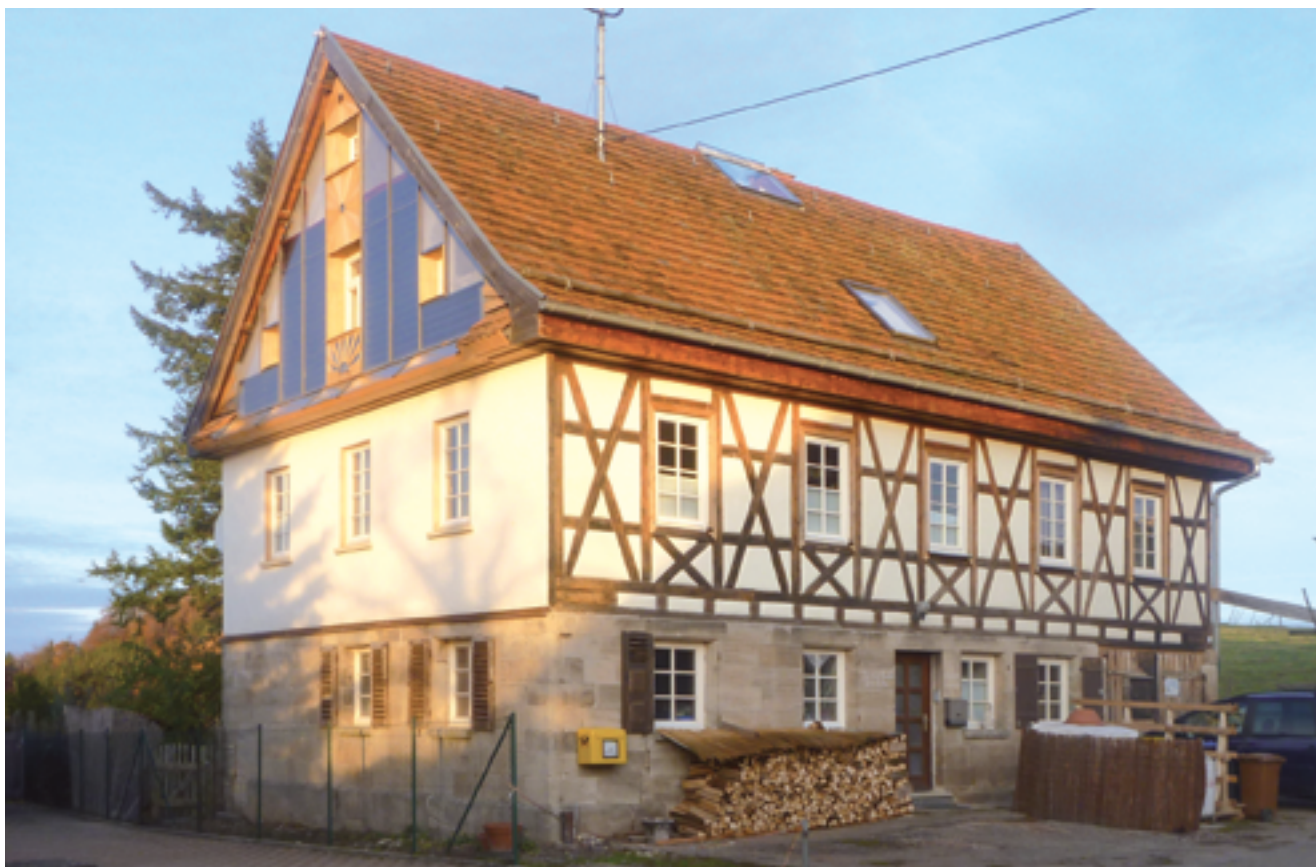
Das über 150 Jahre alte Schulhaus mit Luft- und Wasserkollektoren im Südgiebel
