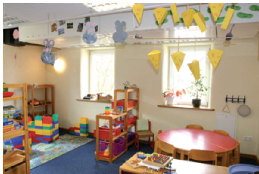
Der fertige Gruppenraum mit Lüftungsanlage (statt abgehängter Decke) und schönen Details wie abgerundeten Fensterleibungen und Fensterbänke aus Eiche
