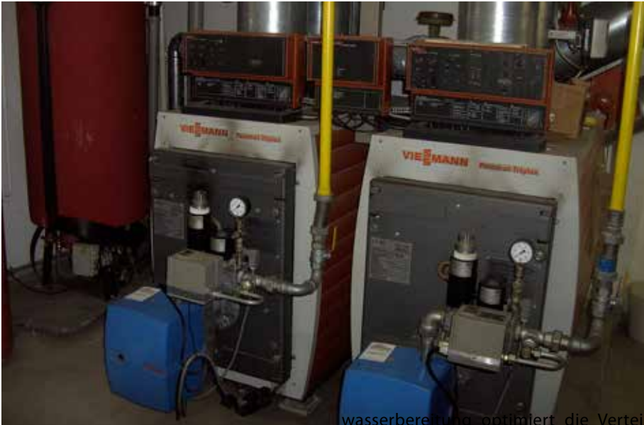
Die Zwillings-Heizungsanlage mit einer Leistung von je 45-111 kW für alle Gebäude wurde ausgebaut.
