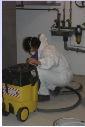
Feinreinigung mit „Asbest“ Staubsauger
