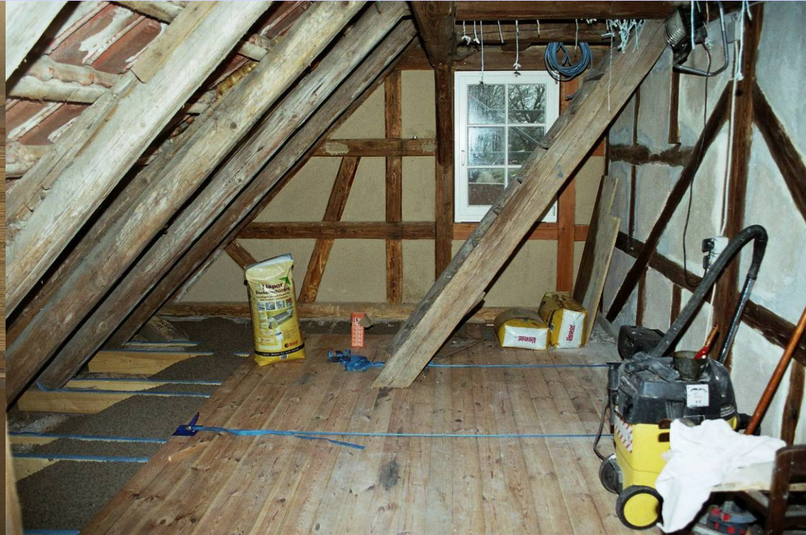
Kork und Blähton zwischen den Balken
