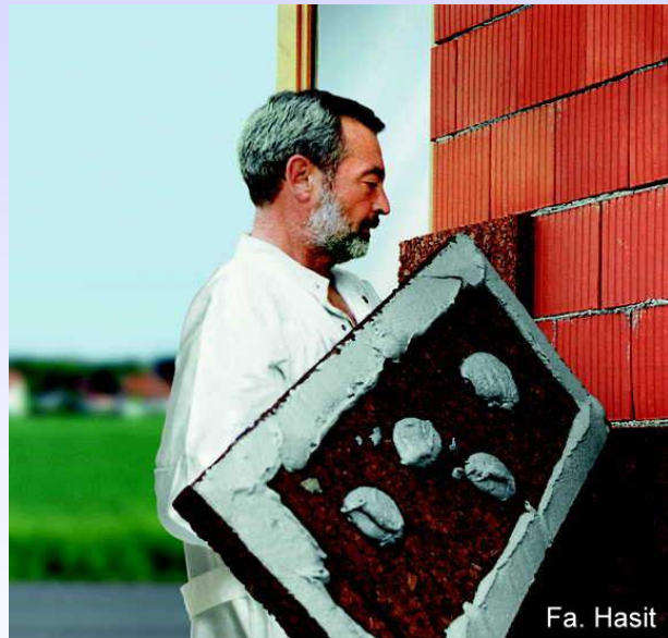
Wärmedämm- verbundsystem
