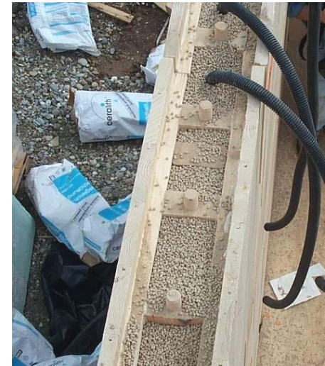
Dach- und Wanddämmung
